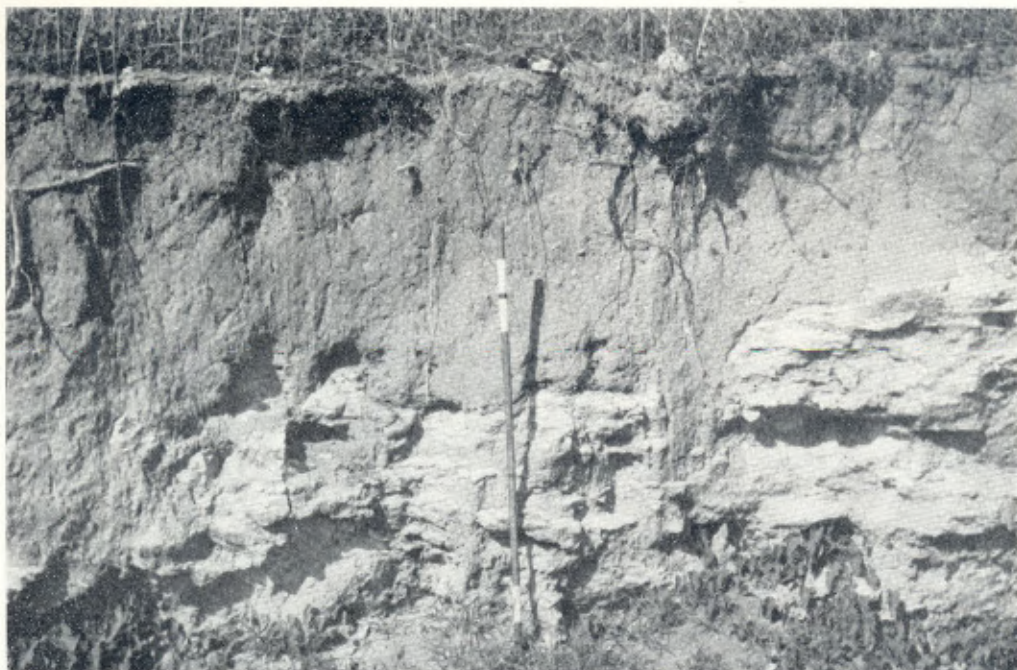
Foto N° 1. Perfil de un corte en una urbanización nueva ubicada en la parte alta de Barranquilla (Carrera 43 y Calle 92), a 90 metros sobre el nivel del mar. La capa superficial de arena compactada y de origen aluvial cubre un estrato de roca caliza margosa que contiene gran cantidad de granos de arena y es de poca dureza. La raya negra de la vara de medir señala 1 metro de altura.
