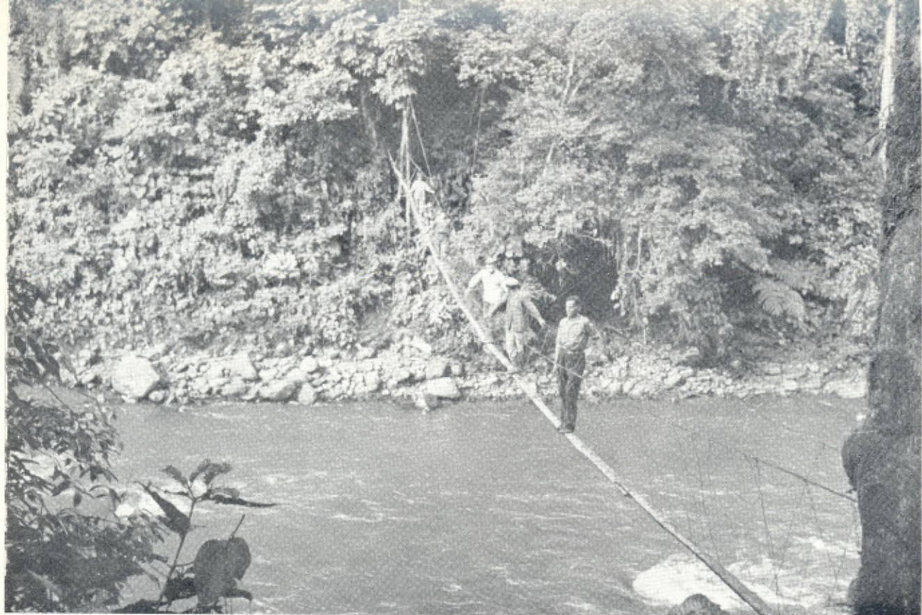
1. Paso aéreo sobre el río Mira por medio de un puente colgante de tablas de "pambil" sostenidas por alambres. Sector de Guadual-Piguambi, kilómetro 287 del ferrocarril Quito - San Lorenzo. Foto MAS: septiembre 12, 1960.
