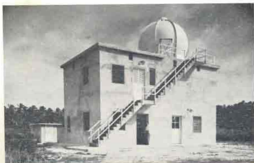
Edificio de la estación de radio-ondas inaugurado en el aeropuerto de la isla de San Andrés, Colombia, en mayo de 1957. La estación funcionó en un local improvisado desde el 26 de noviembre de 1956.
