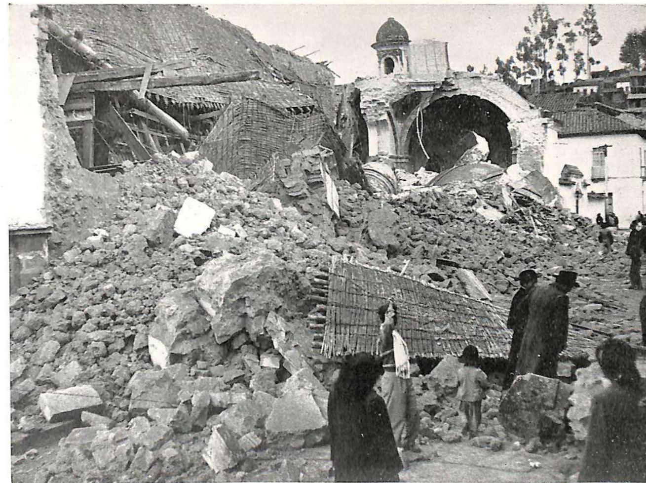
Estado en que quedó la antigua iglesia colonial de Santo Domingo en Ambato.
