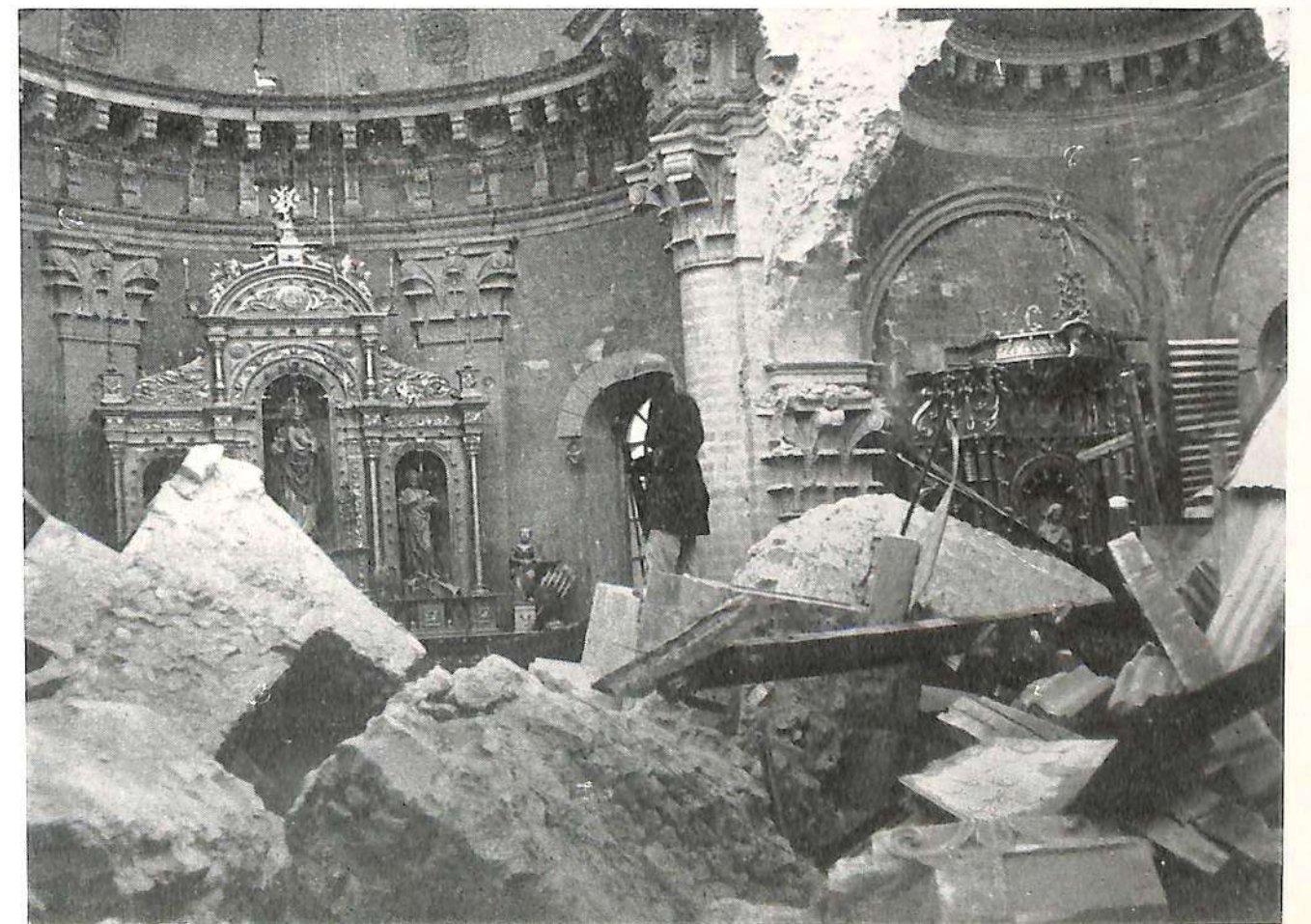
El altar mayor de la nave central de la catedral de Ambato con las ruinas de sus arcos torales. La catedral fue uno de los edificios que mayores daños sufrieron en el terremoto.
