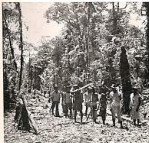
1.—Abriendo el camino de penetración al Bajo Calima, desde La Brea.
