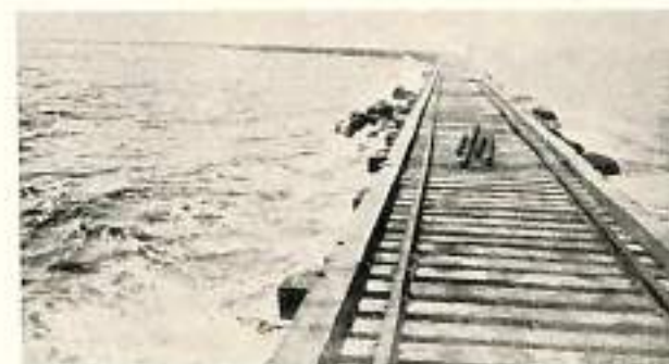
Bocas de Ceniza—Tajamar oriental en construcción
