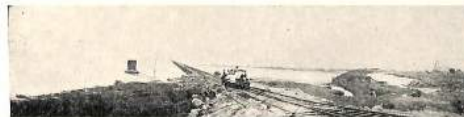
Bocas de Ceniza—Trabajos en el lado oriental para cegar la Ciénaga de Punta Faro.
