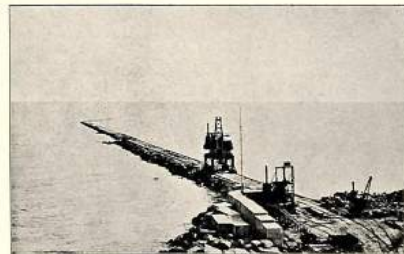
Obras del Puerto de Valencia—Dique del Norte en construcción.
