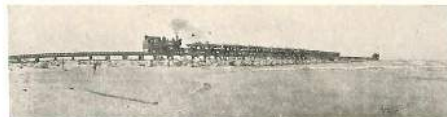
Bocas de Ceniza—Tren con piedra para el relleno de los tajamares.
