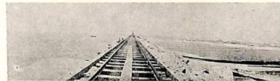
Bocas de Ceniza—Tajamar oriental en construcción
