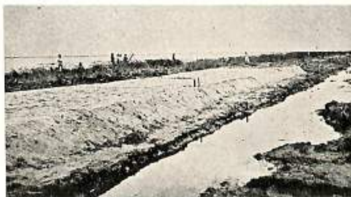
Bocas de Ceniza—Explanación en Punta Caimán para la línea férrea que conduce al tajamar oriental.
