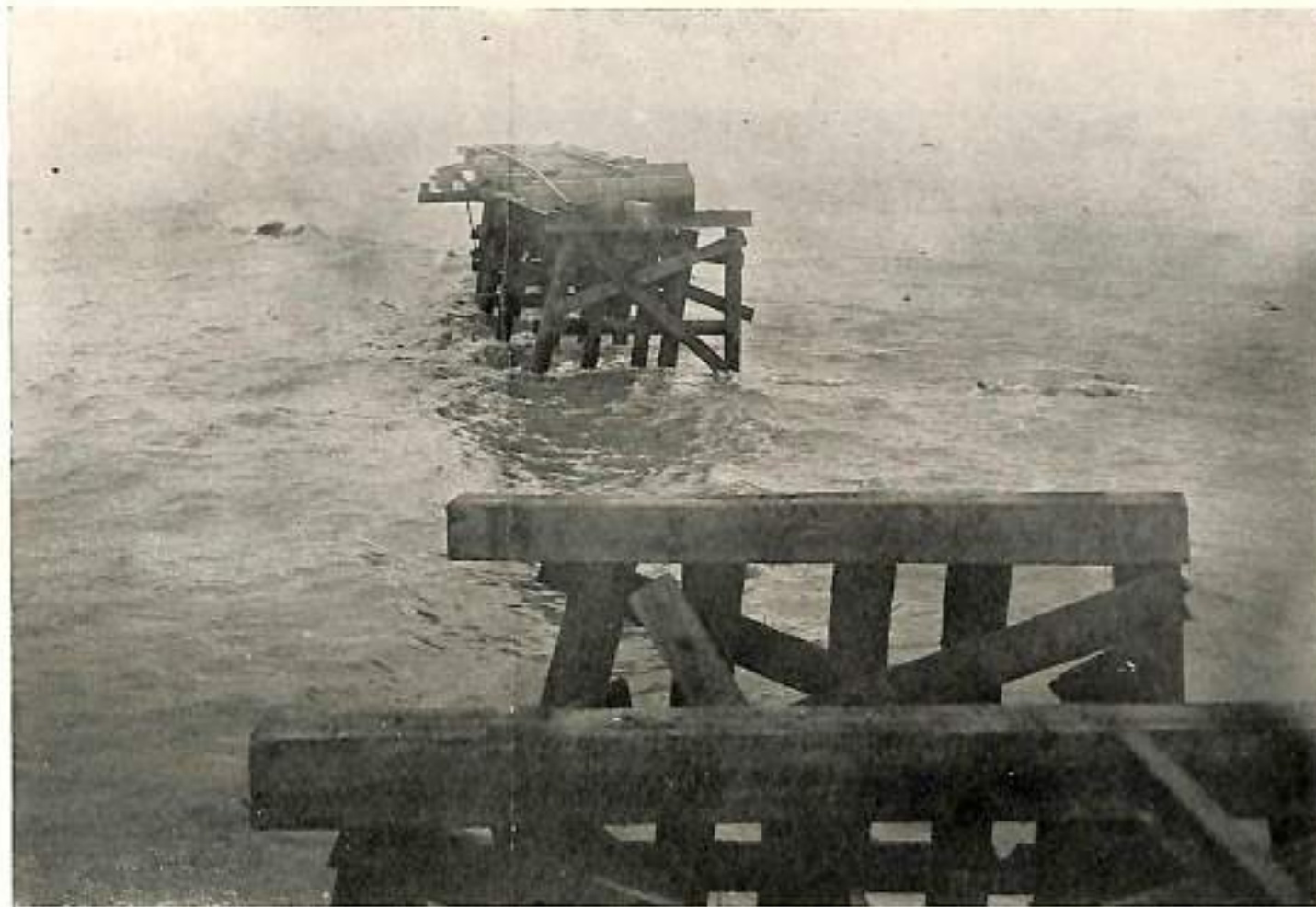
Los llamados "tajamares" en construcción — Frecuente ocurrencia por acción de la corriente del río y el golpe de las olas.
