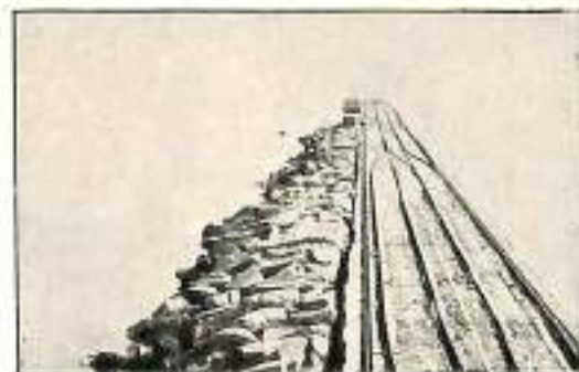
Obras del Puerto de Valencia—Primer tramo del Dique Norte con indicación especial de la escollera.
