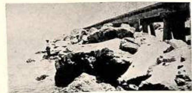
Bocas de Ceniza—Trabajos de relleno en los tajamares.
