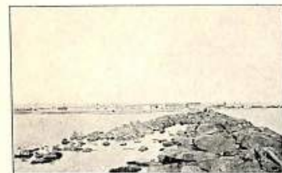
Obras del Puerto de Valencia — El malecón del Turia después del temporal que lo destruyó.
