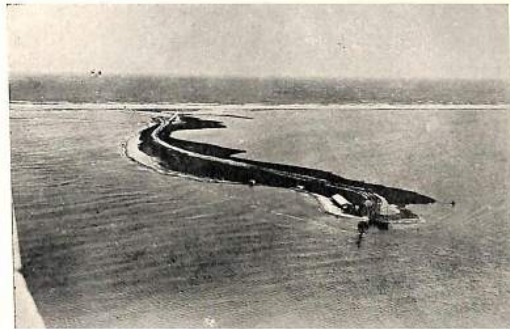
Vista aérea oblicua de Punta Caimán con el muelle de traspaso para el transporte de piedra.
