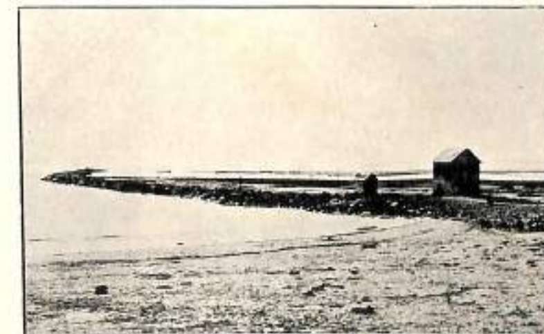
Obras del Puerto de Valencia — Vista del Malecón del Turia antes del temporal que lo destruyó.
