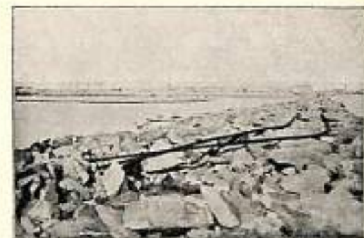
Obras del Puerto de Valencia — El malecón del Turia después del temporal que lo destruyó.
