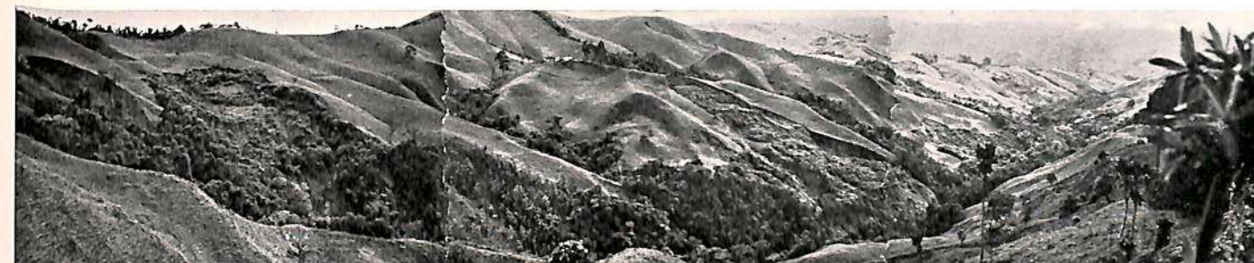
Figura 2.—Comarca típica de deslizamientos y de derrumbes en la parte alta de la quebrada del Guamo, al W. del camino de Manizales al Sinaí. (Véase el croquis explicativo en la figura 5).
