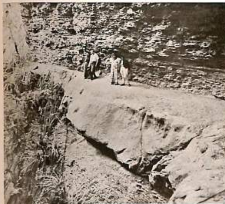
2—Borde del precipicio, hacia la derecha. Aspecto de la grieta, complementario del que muestra la foto No. 1.
