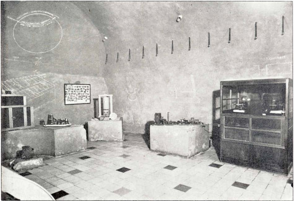
Fotografía del interior de la estación sismológica de Bogotá. A la izquierda y sobre la base de cemento el sismógrafo horizontal Sprengnether, en el fondo el sismógrafo vertical Benioff, a continuación el acelerógrafo tipo Montana y a la derecha dentro de la caja de madera el sismógrafo Wiechert.
