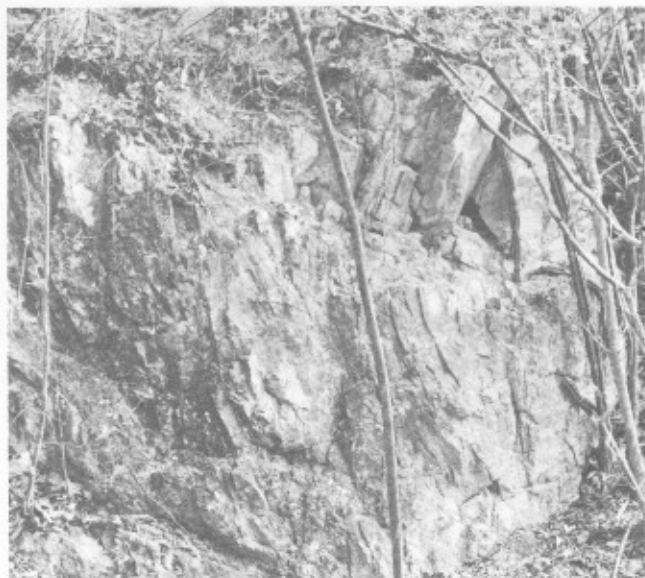
Fotografía 13. Lavas riolíticas con estructuras columnares. Carretera María Angola- Santa Tirsa. R 67032 F28
