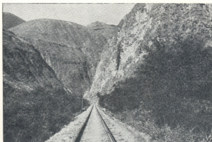
19—Un aspecto del descenso de la línea férrea, siguiendo el curso del río Mira, en "El Avispero" km. 225. Los árboles de los bordes de la línea corresponden a algarrobos o "espinos" ( Acacia pellacantha ). Obsérvese el aspecto erosionado y xerofílico de las laderas de los lados y del fondo. Las plantas más destacadas de las laderas son "cabuyas" ( Fourcroya sp.) y bromelias del suelo y epífitas. Aquí el ambiente o ecología es seco y su vegetación corresponde a Xerofilia Submacrotérmica, faja que abarca de los 1000 a 1600 m. s. m. en el sector noroccidental de Imbabura.
